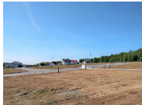
Baugebiet Feldle I, Lipfersberg Erschließung 2. Bauabschnitt Bild: 05/2020
