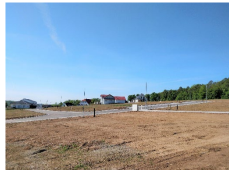
Baugebiet Feldle I, Lipfersberg, 2. Bauabschnitt Bild: 05/2020
