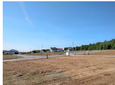
Baugebiet Feldle I, Lipfersberg, 2. Bauabschnitt Bild: 05/2020
